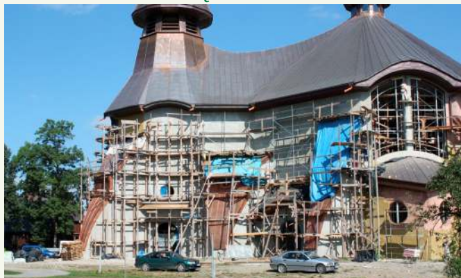
↑ W 2012 roku wykonano również docieplenie całego budynku oraz elewację zewnętrzną, z wiosną rozpoczęto montaż stolarki okiennej
