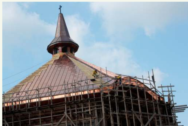
Ekipa budowlana przystępuje do wykonania potężnej ↑ wieży dachowej na całym kościele, która jest na bieżąco przykrywana blachą miedzianą
