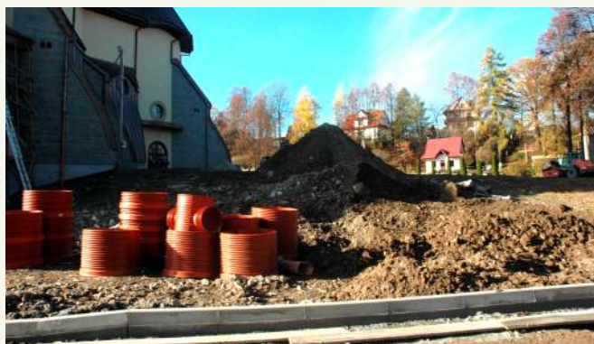
Październik - wykonywane jest odwodnienie ↑ oraz parking wokół kościoła
