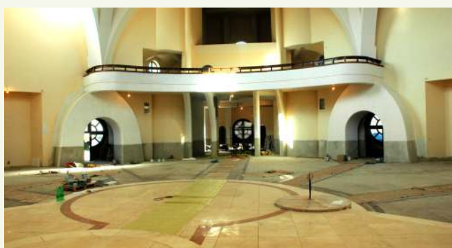
Rozpoczyna się malowanie kościoła. Kładzione są ↑ granitowe posadzki oraz wykonywane jest ogrzewanie
