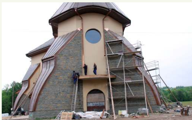
Do pracy wchodzi ekipa kamieniarzy ze Słopnic. ↑ Kamienie są układane na tzw. wzór słopnicki, który chyba wejdzie do historii architektury
