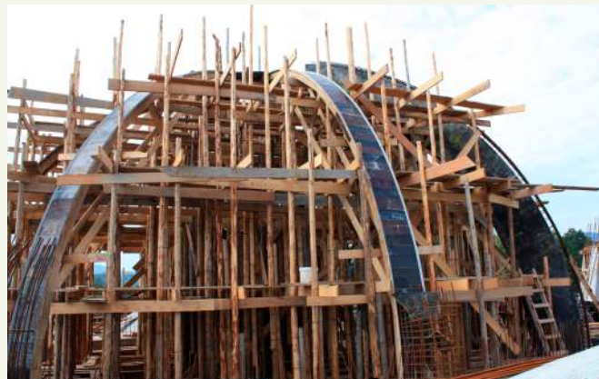
Ponad murami pojawia się żelbetowa konstrukcja ↑ wieży oraz rozpoczyna się budowa konstrukcji kopuły zwieńczającej nawę. Setki żerdzi, setki ton stali, tysiące metrów sześciennych betonu i wiele ludzkiego wysiłku, potu oraz ofiarności parafian przynoszą efekty
