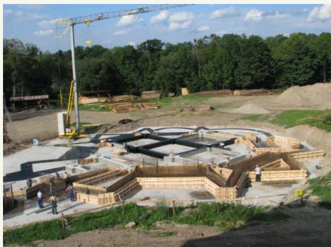
↑ W okresie od lipca do listopada 2008 roku wykonano ławy i ściany fundamentów, które następnie zakończono płytą
