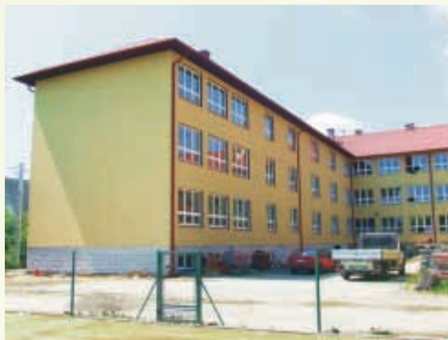
Nowe skrzydło architektonicznie dostosowane jest do istniejącej już starej części budynku ↑
