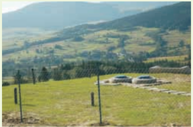
Zbiornik wyrównawczy w Podgórzu ↑ ze stacją uzdatniania wody
