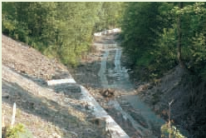
↑ Umocnienie korpusu drogi od strony potoku Mogielica
