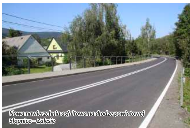
Korpus drogi powiatowej Słopnice-Zalesie
