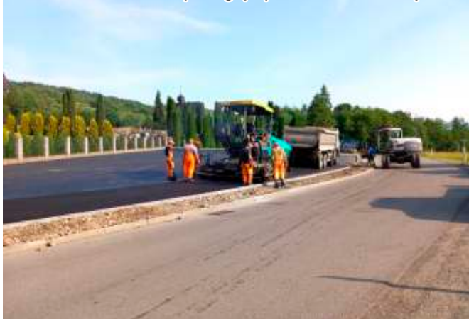
Prace w zakresie remontu parkingu przy kościele w osiedlu Zarąbki
